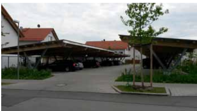
Sammelgarage Baugebiet „Ziegelei“ in Baierbrunn
