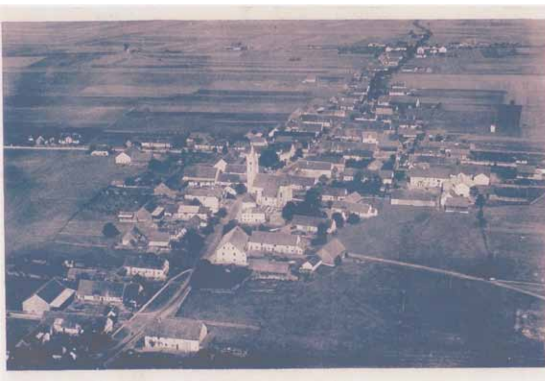
Luftaufnahme mit hist. Ortskern und Straße zum Bahnhof, um 1921; Quelle: Gemeinde Neufahrn
