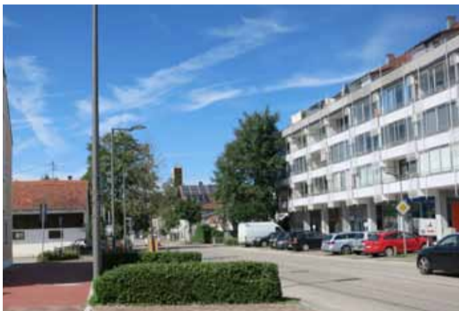
heterogene Baustruktur und strukturelle Brüche
