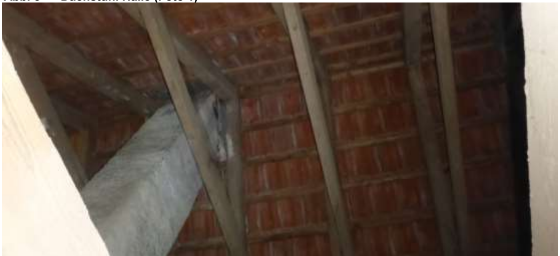
Abb. 6 Dachstuhl Halle (Foto 2)
