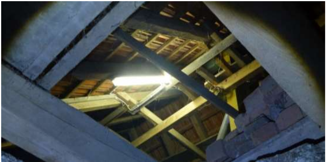
Abb. 10 Dachstuhl Getreidespeicher (Foto 1)
