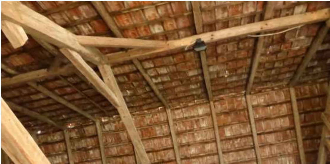
Abb. 5 Dachstuhl Halle (Foto 1)
