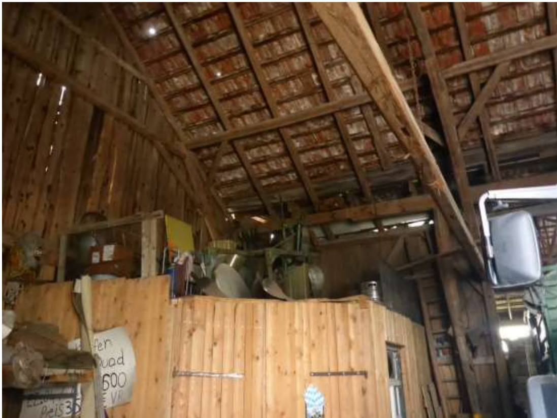
Abb. 8 Dachstuhl Halle (Foto 3)
