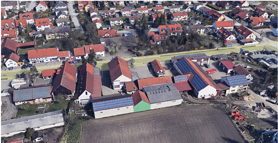
Schrägluftbild von Westen: „Baulicher Bestand“ – Quelle: Google Earth – © 2009 GeoBasis-DE/BKG - © 2019 Google 07.09.2022
