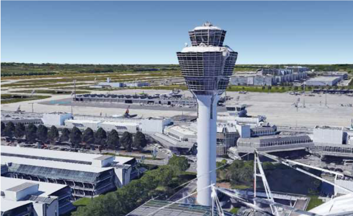
Abbildung 21 Blick vom Tower in Richtung der PV-Anlage (IP 14)
