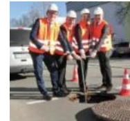
2017 FW Netz Querung A9 Eching
