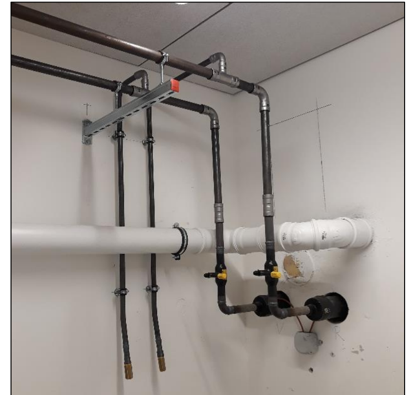
Fernwärme- Hausanschluss
