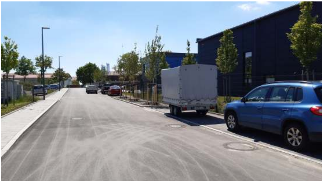
Anlage kleiner Blühflächen in den baumbestandenen Pflanzstreifen
