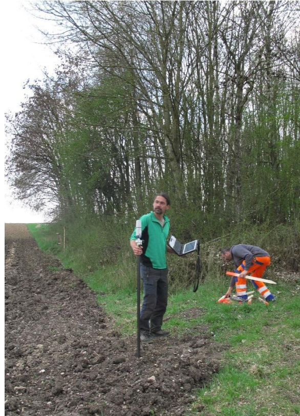
Absteckarbeiten durch Bauhof und Forst in Giggenhausen (Schaidenhausen)
